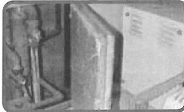
Conduit amiante-ciment
