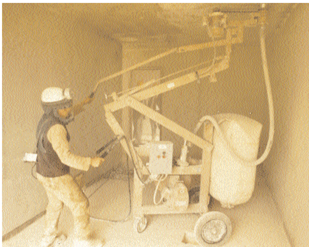
Ponçage d'un plafond en béton.
